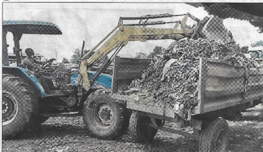
► Les engins déblayent les dépôts des pluies diluviennes.
